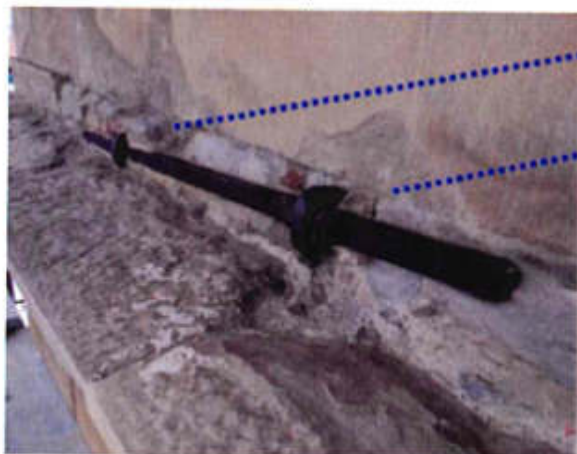
Cinematisma di ribaltamento attivato in facciata corretto dall'azione di trattenuta dei tiranti disposti in corrispondenza dei cantonali alla quota del cornicione intermedio: effetto di rigonfiamento al centro della parete trattenuta
